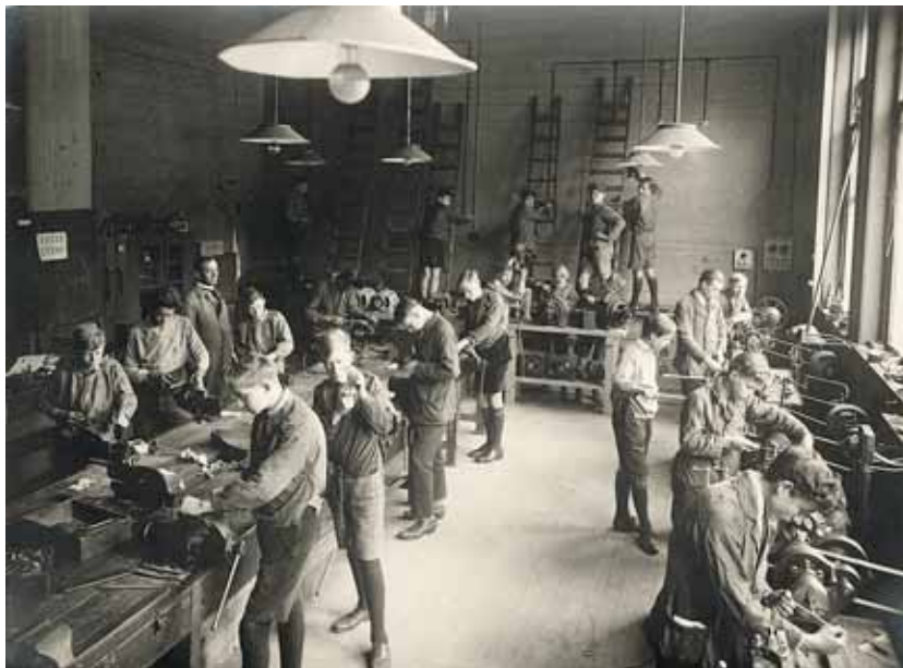
Werkplaats van de elektriciens in opleiding ( Rotterdamsche Ambachtsschool omstreeks 1925 ). Op de achterwand van het lokaal werden elektrische installaties in model nagebouwd.
