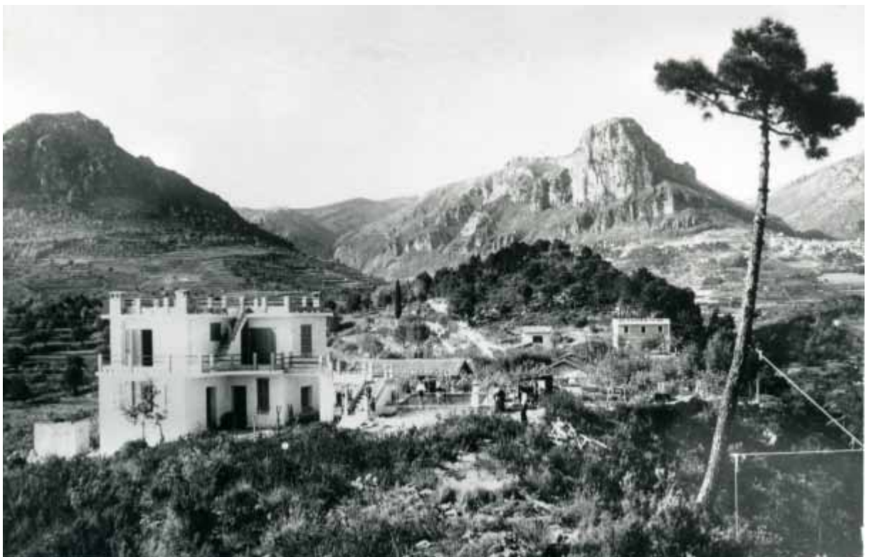
De Freinetschool in Vence in aanbouw
